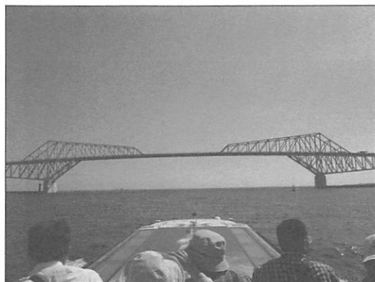
（東京ゲートブリッジ）
