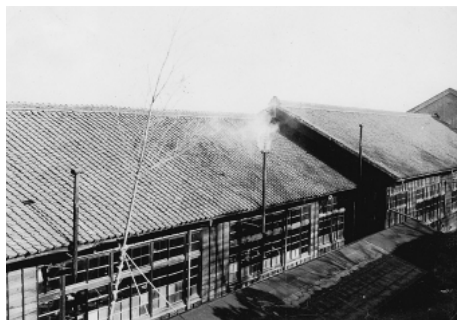
昭和26年完成の独立校舎
